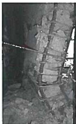
Figura 1. Pandeo fuera de plano de un muro estructural (Sri Sritharan, 2011)
