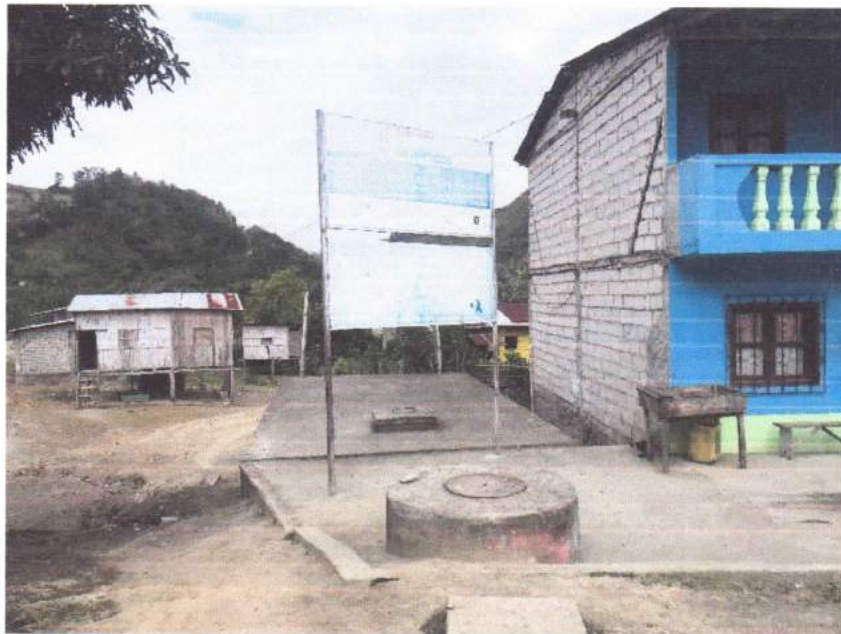
Pozo séptico próximo al parque central
