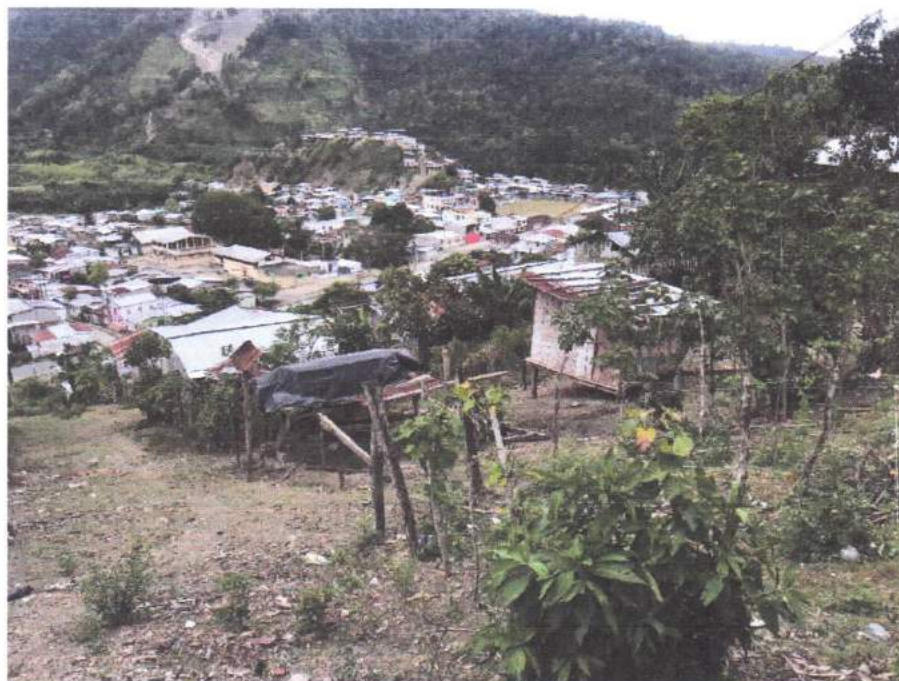
Aproximación al tanque elevado sin planta de tratamiento de agua potable
